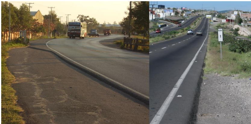
Figura 27: Ejemplo de Desniveles por Recapado
