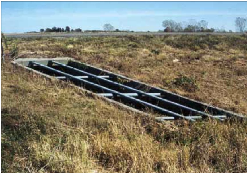
Figura 14: Ejemplo de Tratamiento Seguro de Alcantarillas Transversales
