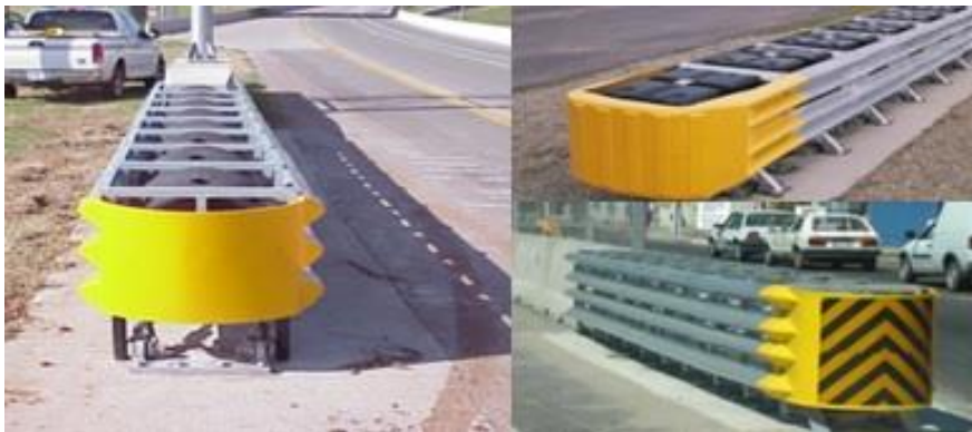
Figura 10: Ejemplo de Amortiguador de Impacto con capacidad de redireccionamiento
