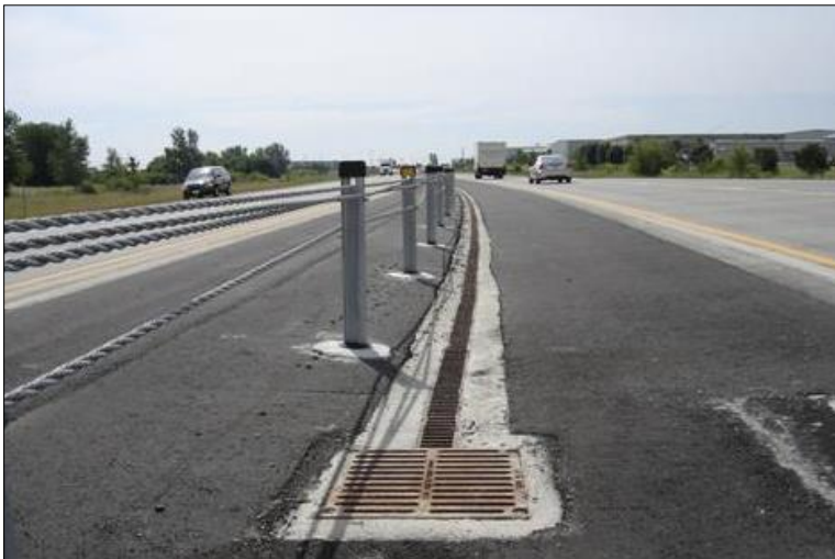
Figura 7: Ejemplo de Sumidero en el Separador Central
