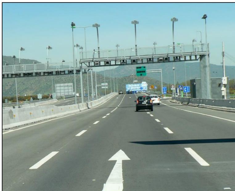
Figura 53. Infraestructura Típica de Tele-Peaje
