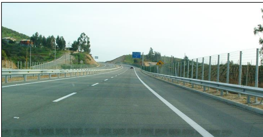
Figura 32: Ejemplo de Control de Acceso en Autopista
