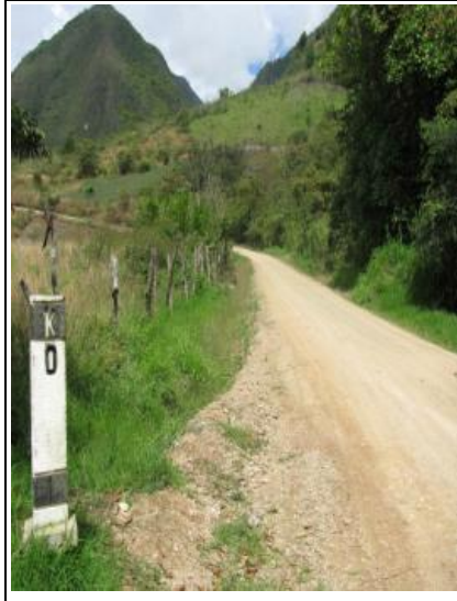
FOTOGRAFIA PUNTO INICIAL (OBRA)
