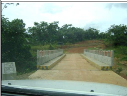
Foto 05: Puente de Concreto, en servicio. Con Plataforma, Veredas y Barandales en buen esta operativo.
