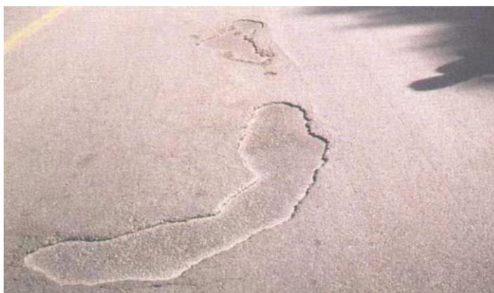
**Gravedad 2: Continuo sin aparición de la base granular o puntual con aparición de la base granular**
