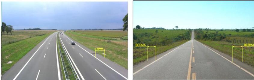
**Figura II.49 Medición del ancho de berma**
