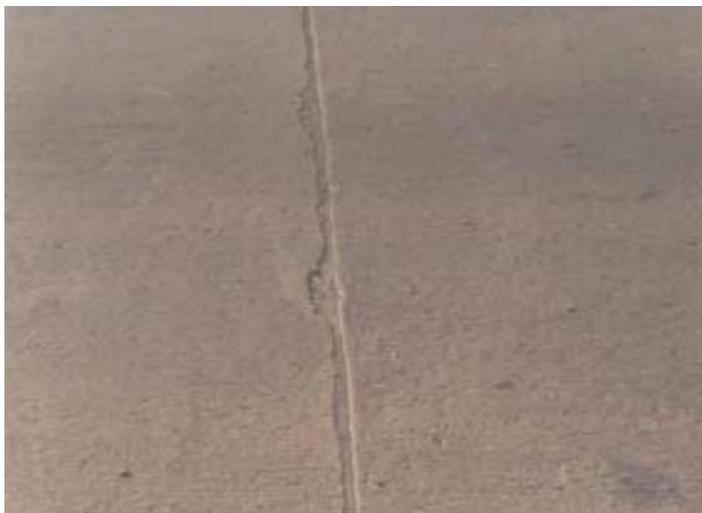
**Gravedad 2: Fracturamiento o desintegración de bordes en más que el 50 % de la longitud dentro de los 5 cm de la junta**
