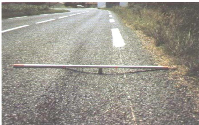
**Deformaciones (3b hundimiento)****Gravedad 2: Profundidad entre 2 cm y 4 cm**
