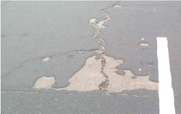
**Gravedad 2: Desprendimiento entre el 10% y 50% de la superficie de losa afectada**
