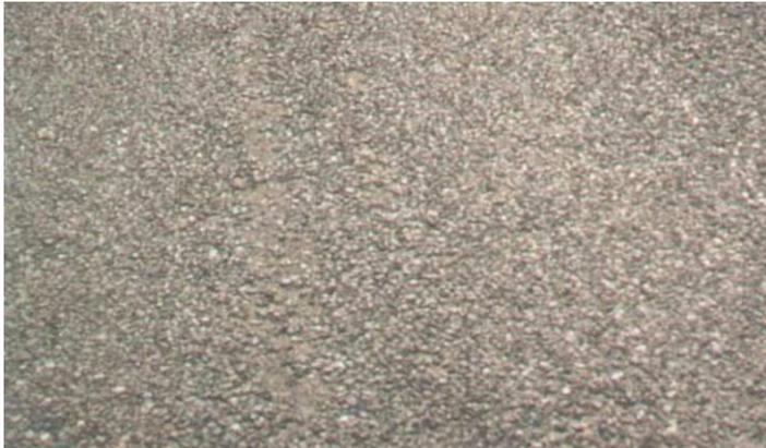
**Gravedad 1: Puntual sin aparición de la base granular (concreto asfáltico)**
