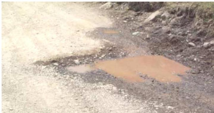
**Gravedad 2: Se necesita una capa de material adicional**
