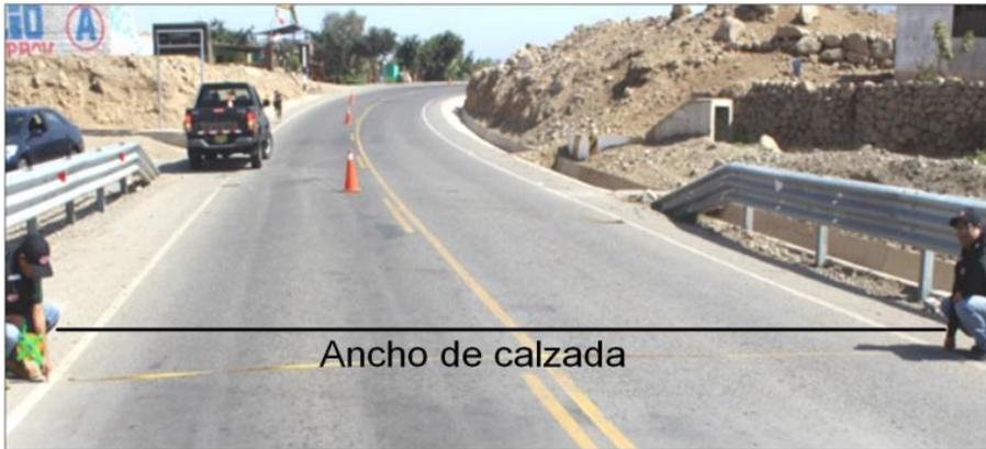
**Figura II.47 Ancho útil para carretera no pavimentada**
