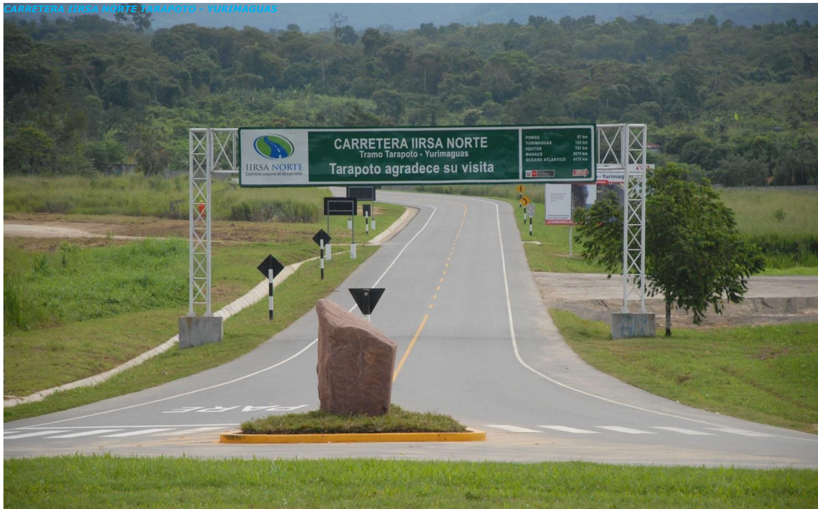
CARRETERA IIRSA NORTE TARAPOTO - YURIMAGUAS
