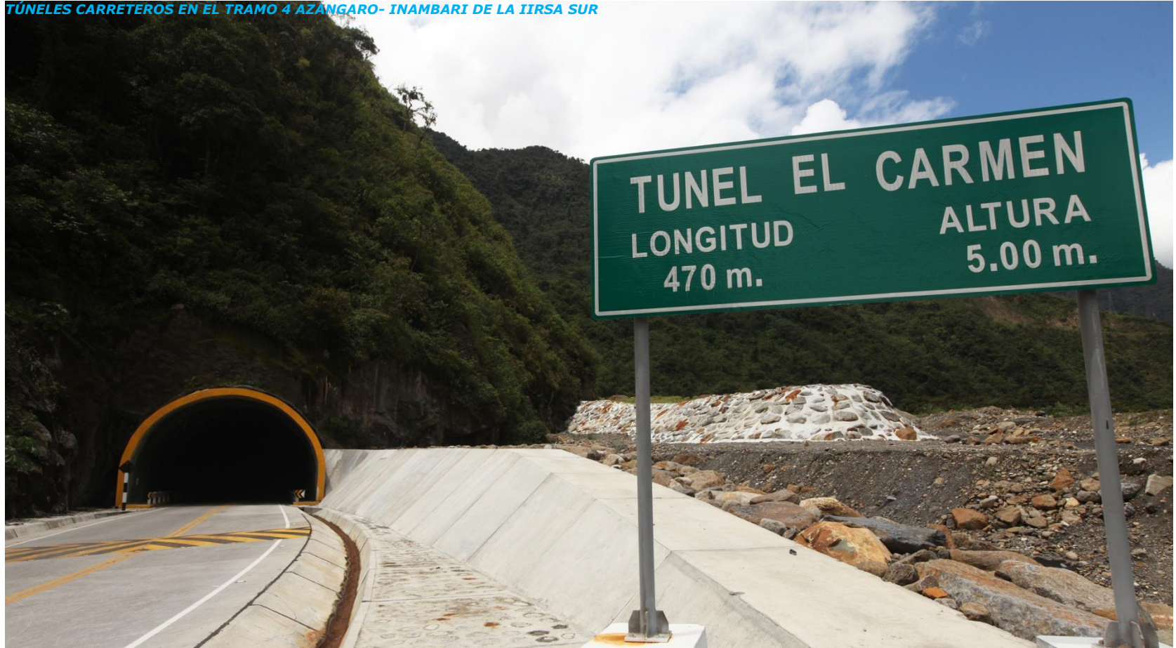
TÚNELES CARRETEROS EN EL TRAMO 4 AZANGARO- INAMBARI DE LA IIRSA SUR
