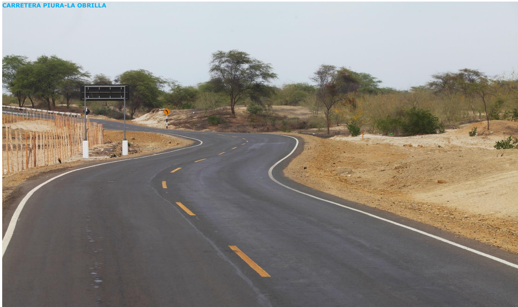
CARRETERA PIURA-LA OBRILLA
