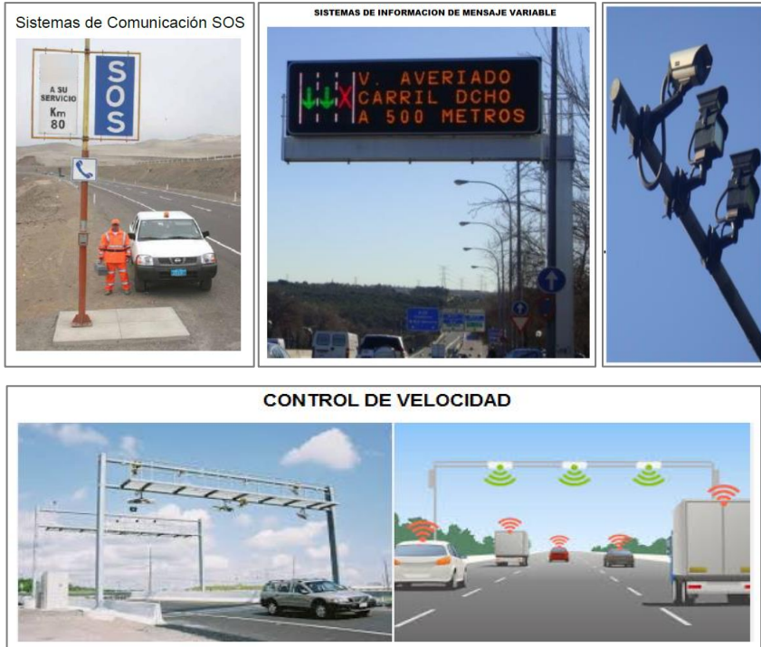
Figura 2.54 Ejemplo de pórtico con dispositivos de medición de velocidad como sistema inteligente de transporte (ITS)
