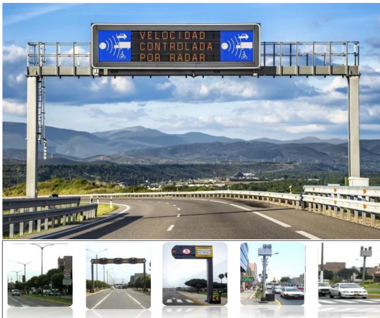
Figura 2.53 Ejemplo de sistema de fiscalización electrónica
